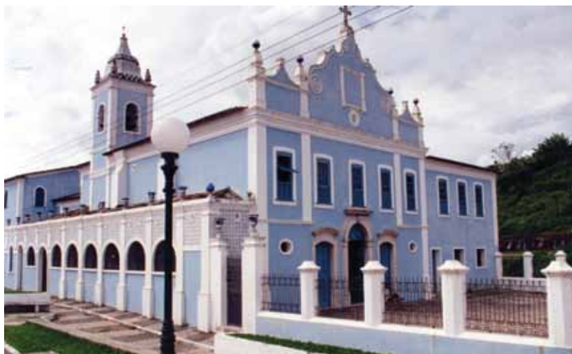
Figura 1 - Igreja e Convento do Recolhimento de Nossa Senhora dos Humildes, Santo Amaro da Purificação, Bahia.
