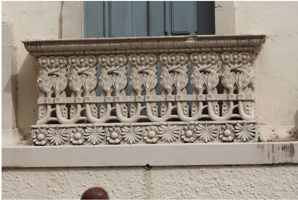
Figura 3 – Balcão da janela da fachada da Igreja Matriz de Nossa Senhora de Nazaré, Nazaré das Farinhas, Bahia. Foto: Luiz Freire.
