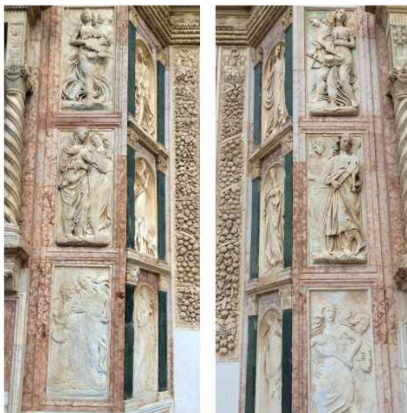
AGOSTINO DI DUCCIO. Oratório de São Bernardino. Perugia. 1452. Vista frontal do grande portal de entrada. Fonte: a autora.
